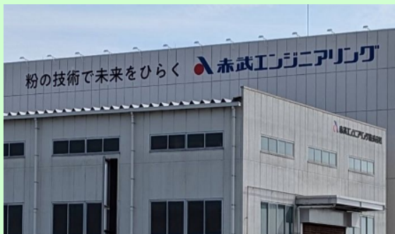
本社・工場棟北側壁面に新たな看板を設置しました
